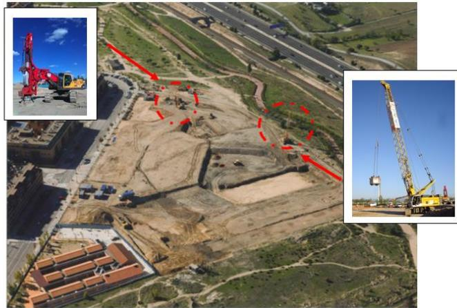
Figura 11. Método de ejecución. Combinación de compactación dinámica tradicional profunda (CD) y compactación dinámica rápida o superficial (RIC)
